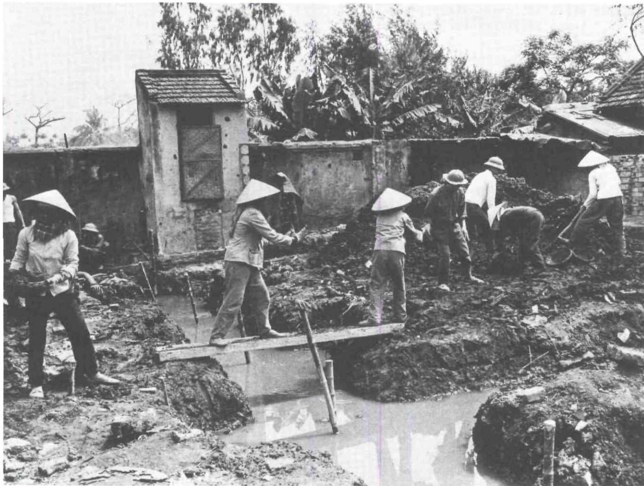
Préparation des fondements pour une des 184 écoles construites en 1977.
